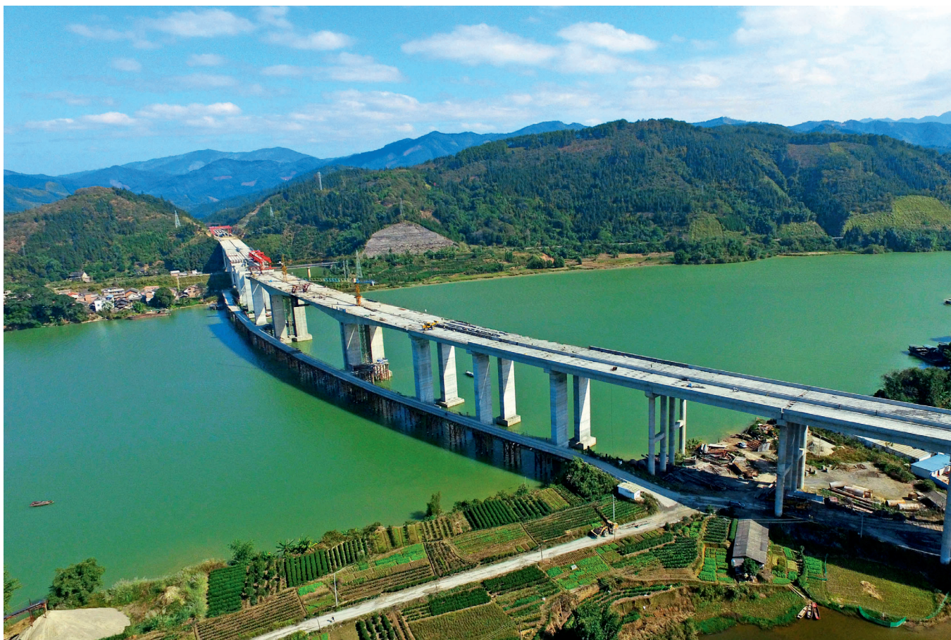
2016年11月11日，正在建设中的广西三柳高速公路施工现场。
